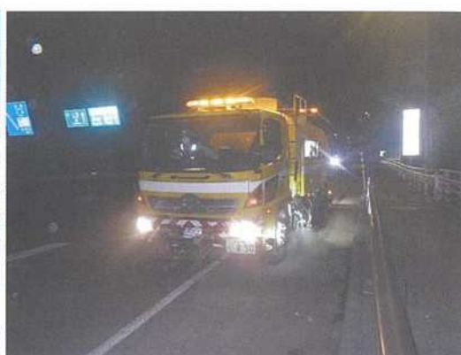
<交通量の多い幹線道路での夜間作業>
