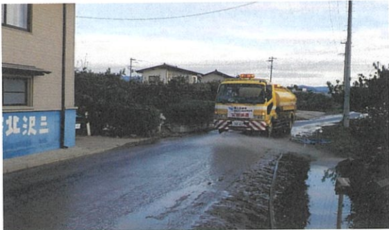
福島県伊達郡桑折町内で流入した土砂の撤去作業を行う路面清掃車と散水車
