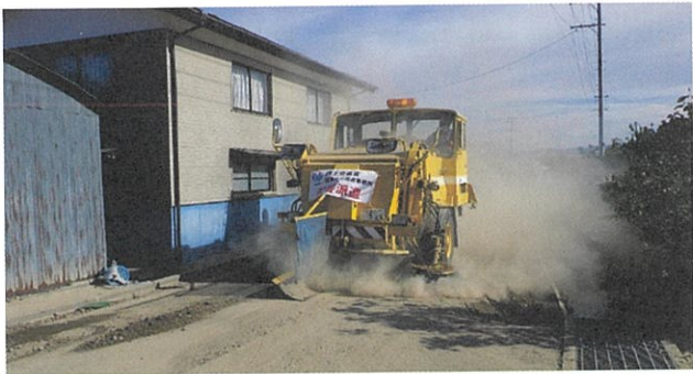
福島県伊達郡桑折町内で流入した土砂の撤去作業を行う路面清掃車と散水車
