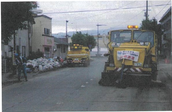
伊達市梁川町地内に流入した土砂の撤去作業
