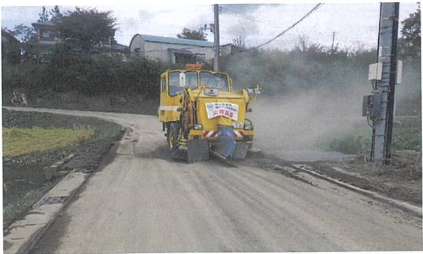
伊達郡国見町地内に流入した土砂の撤去作業
