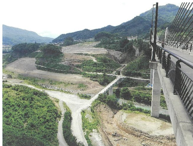
不動大橋より旧 JR 線を望む
