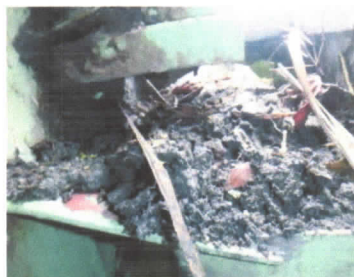
橋梁伸縮装置の 清掃前と清掃後
