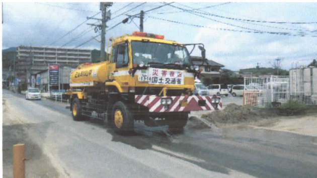
朝倉市内での散水作業状況（写真提供関東地方整備局）
