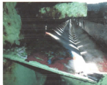
橋梁伸縮装置の 清掃前と清掃後
