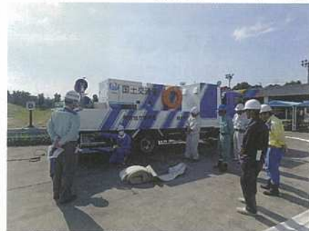
内水排除のための排水ポンプ車の展開
