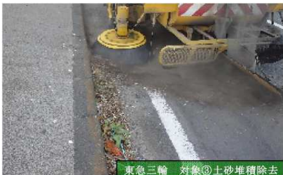
東急三輪 対象③土砂堆積除去
