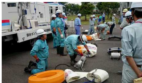
②排水ポンプ車の訓練実施状況：協会員が撮影
